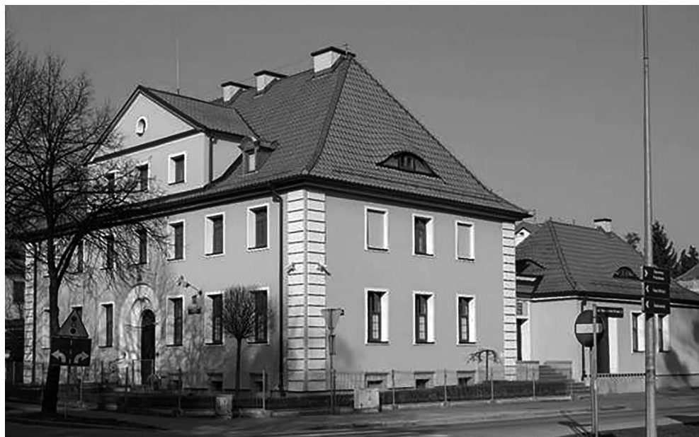
Ryc. 5. Budynek Urzędu Miar w Elblągu z 1926 roku (stan obecny).
